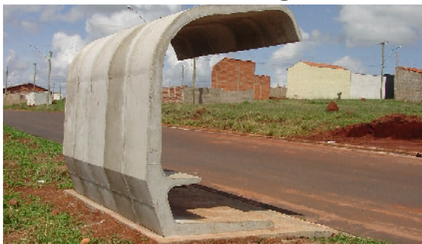
Um dos abrigos instalados no Jardim Itamaraty
