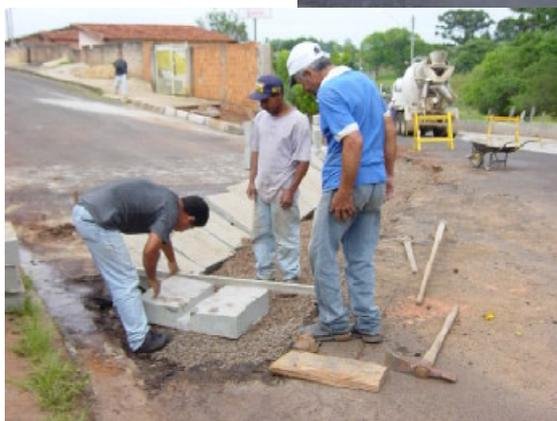
ta-se de uma reivindicação antiga dos moradores do Recanto Azul. Em virtude do estado de deterioração da rua, o tapa-buracos não era mais eficiente, daí a necessidade de recapear a rua. Também foi necessária a construção de uma canaleta de concreto no cruzamento com a rua dos Costas.
