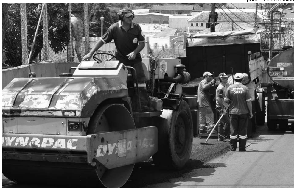
Foram utilizadas mais de 200 toneladas de massa asfáltica no trecho
