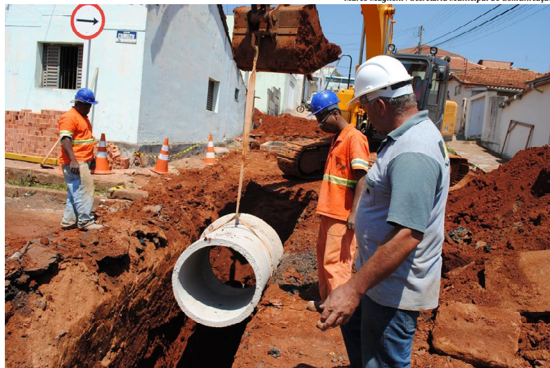
Tubulações de concreto somarão 390 metros de extensão e oferecerá maior vazão às águas das chuvas
