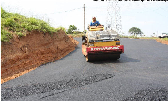
No Jardim Tropical trecho de 1.450m² do acesso ao loteamento foi pavimentado
